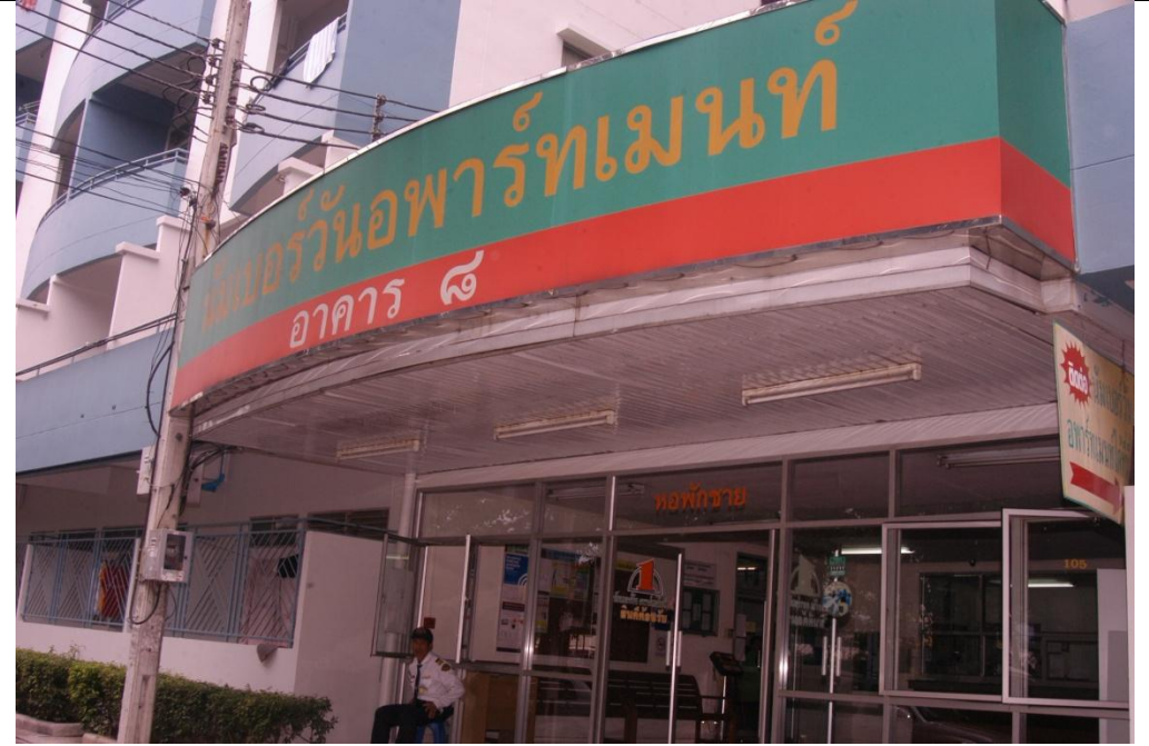
หอพักชาย นัมเบอร์วันอพาร์ทเมนต์ รามฯ 2 ★★★★★
